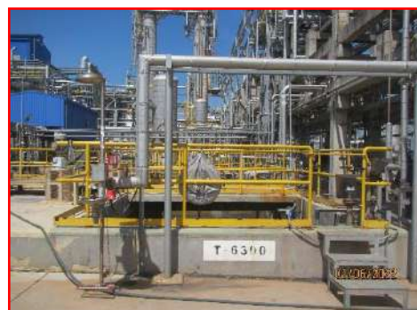
ภาพที่ 2-11 ถังปรับสภาพน้ำให้เป็นกลาง
