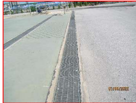
ภาพที่ 2-16 รางระบายน้ำฝนที่ไม่ปนเปื้อน
