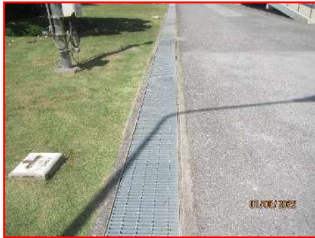
ภาพที่ 2-16 รางระบายน้ำฝนที่ไม่ปนเปื้อน
