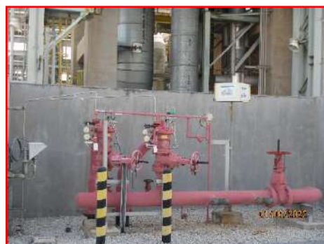
ภาพที่ 2-35 การติดตั้งระบบดับเพลิงภายในพื้นที่โครงการ
